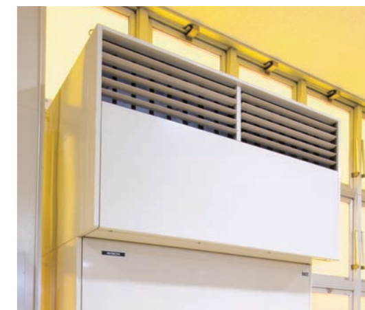
HEPAフィルターを装備したクリーンルーム用の空調機
